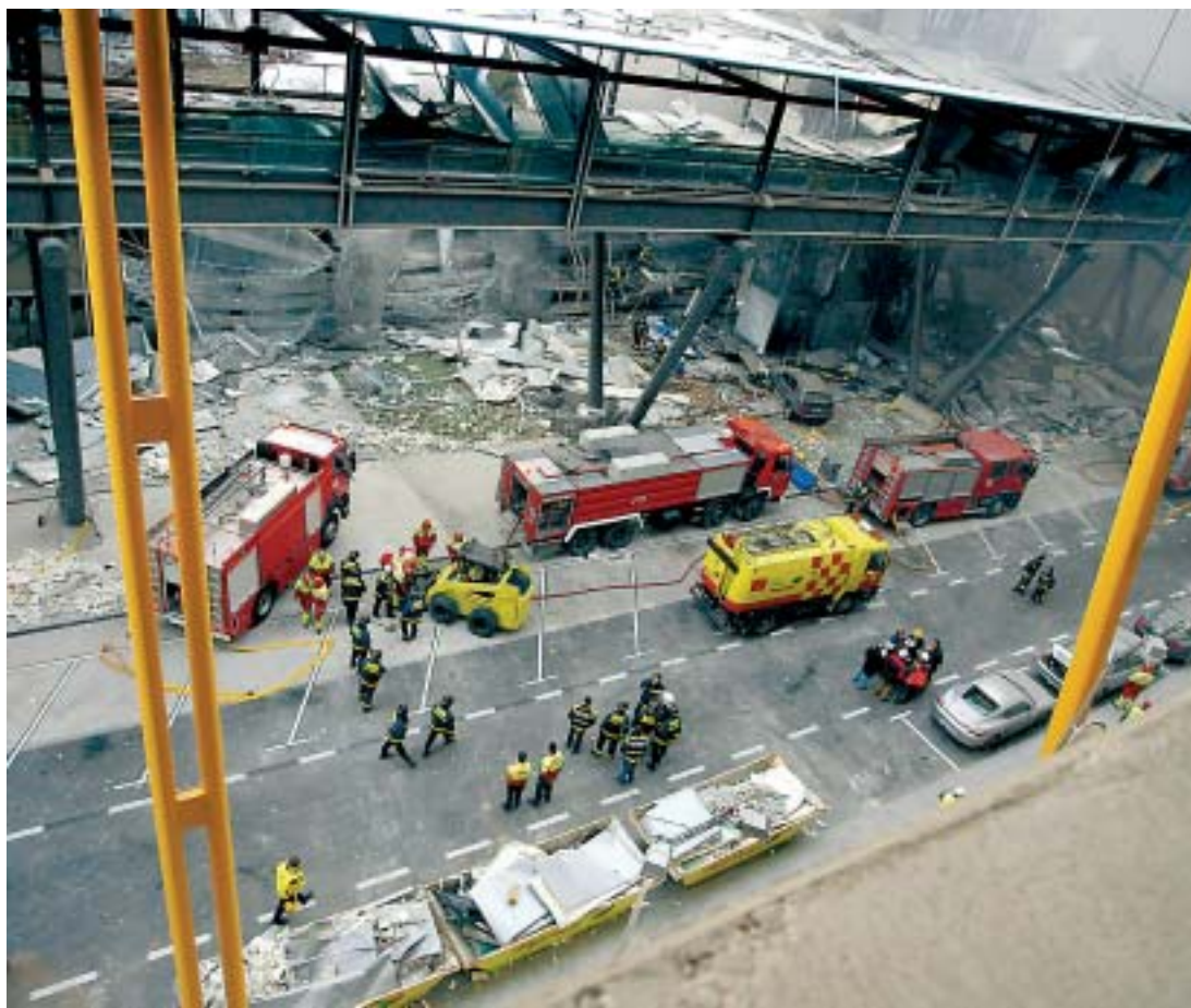
El módulo D del aparcamiento de la terminal T-4 de Barajas quedó totalmente destruido por la explosión. | EFE
